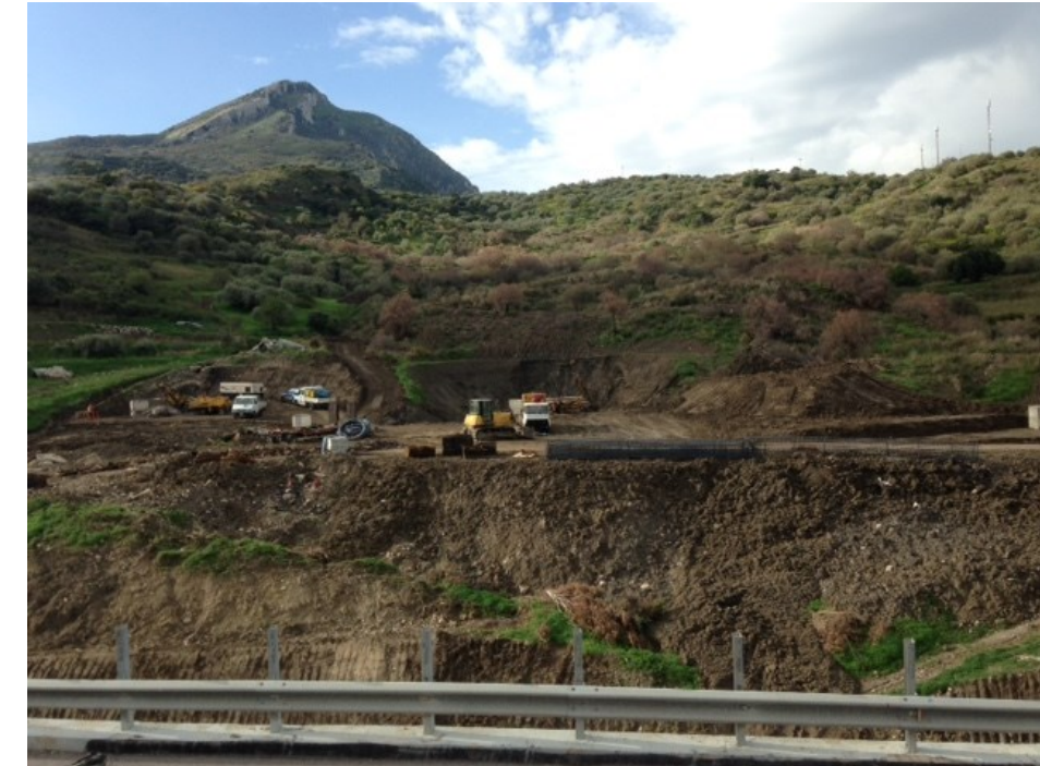
Area del versante sud, interessata dai lavori di decostruzione delle campate del viadotto Imera tra le pile 16-22 carr.dir CT
