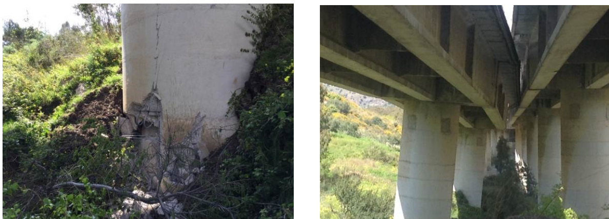
Viadotto IMERA I
