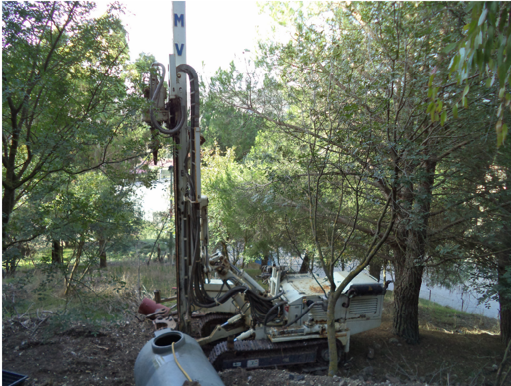
Foto n. 9: sondaggio stratigrafico S3
