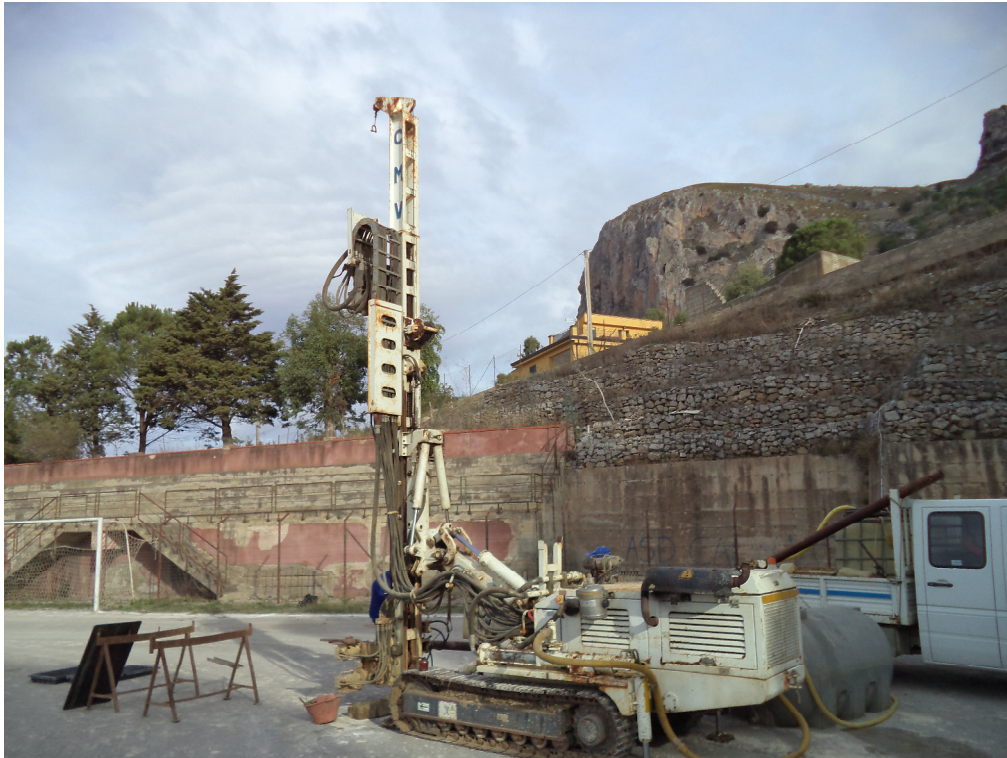
Foto n. 1: sondaggio stratigrafico S1
