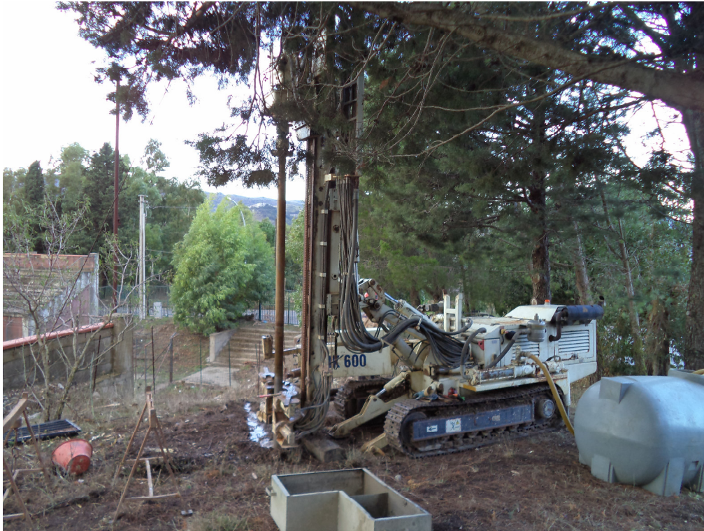
Foto n. 5: sondaggio stratigrafico S2
