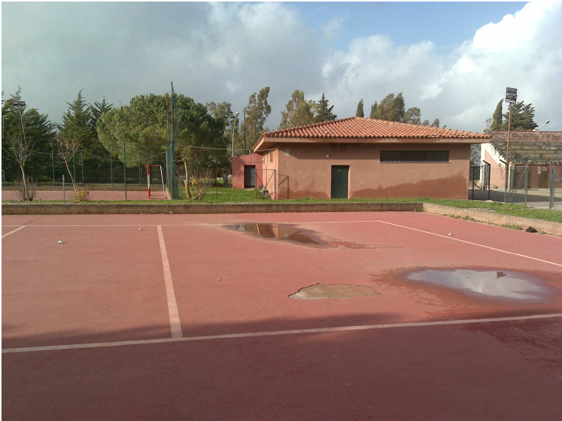
foto n. 7 – fabbricato spogliatoi e campi
